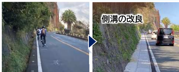
県道須走小山線(小山町)
