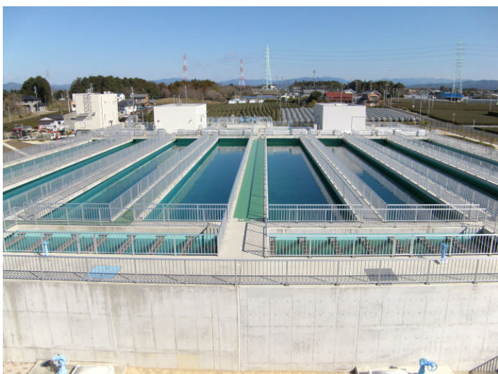
遠州水道 寺谷浄水場
