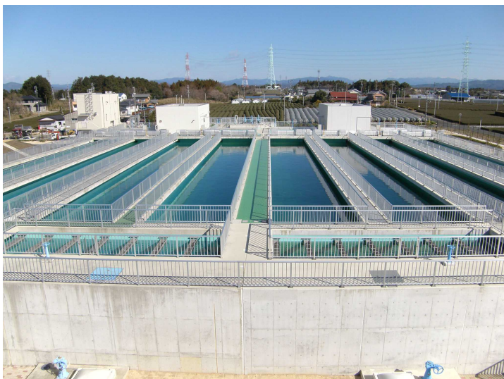
遠州水道 寺谷浄水場
