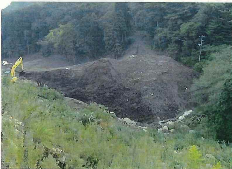
2010(平成22)年10月13日 調圧槽手前に大量の土砂を確認
