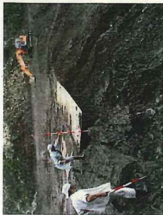
雨水により、開発地の転圧不足の土砂が 流れ出ていることを確認。
