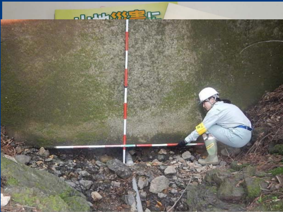
治山施設の点検
