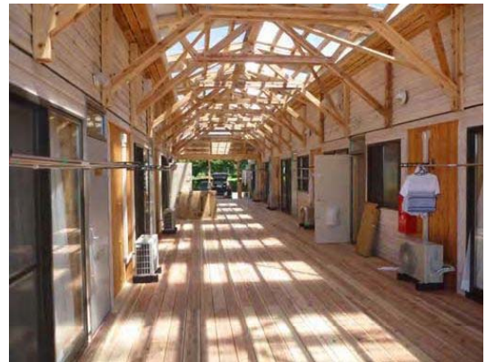
【コミュニティ配慮型の木造仮設住宅】
