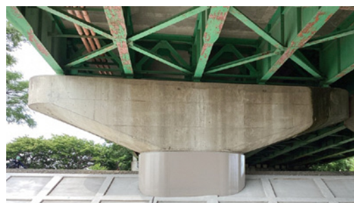
(国)150号 新瀬戸川橋
