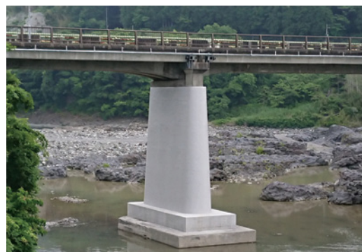
(主)富士川身延線 内房橋
