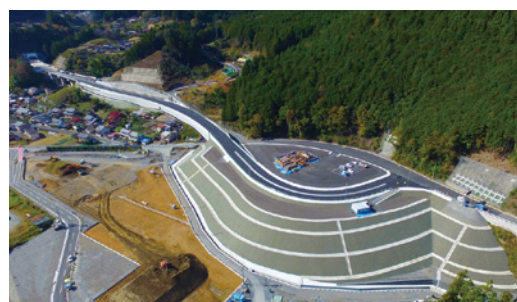
三遠南信自動車道(水窪佐久間道路)
