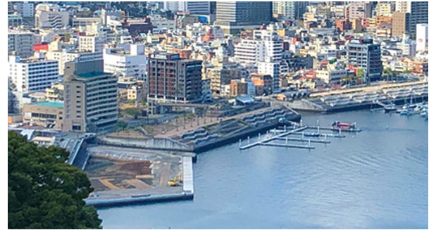
熱海港海岸（海岸堤防）
