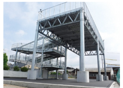
津波避難タワー
