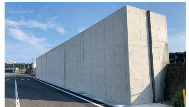
御前崎港海岸（胸壁）
