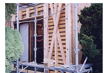
木造住宅耐震改修
