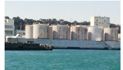
御前崎港海岸防潮堤（胸壁）
