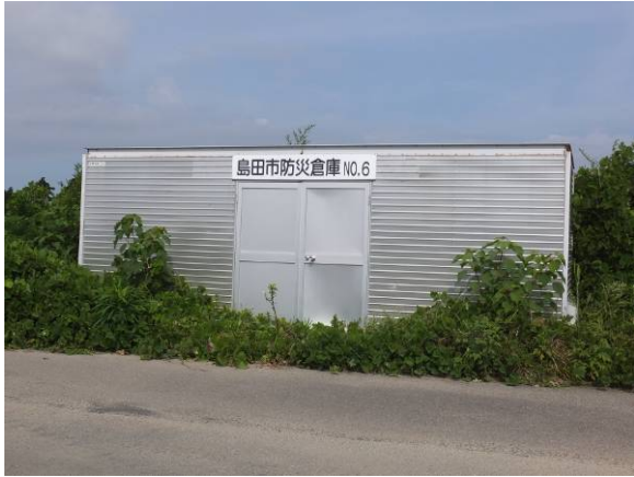
③島田市防災倉庫
