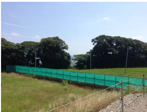
⑤外周単管柵、シート
