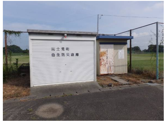
④富士見町防災倉庫、リサイクルボックス
