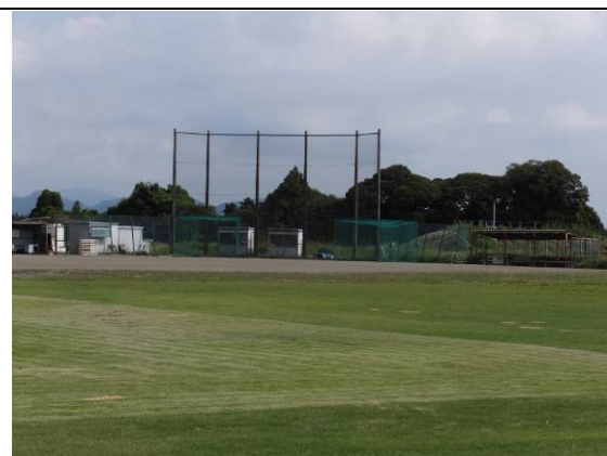
②野球場関連施設 (バックネット、フェンス等)
