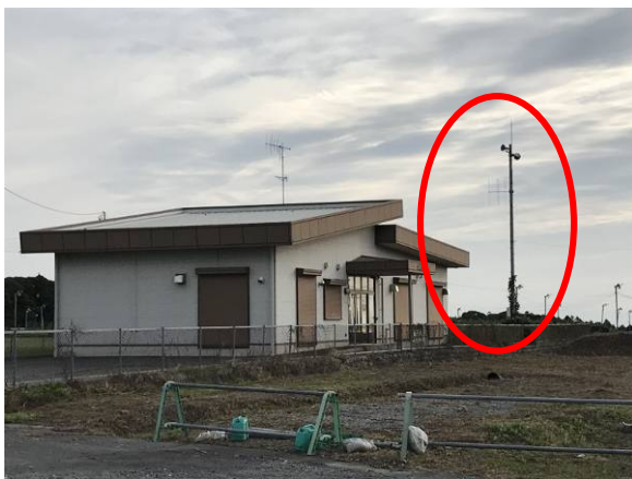
⑦島田市同報系防災行政無線
