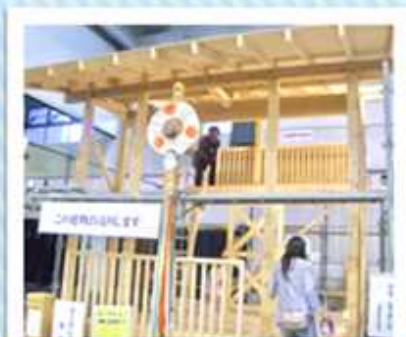
Construção estrutural com madeira
