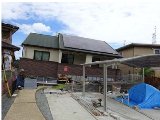
写真4 倒壊した木造住宅
