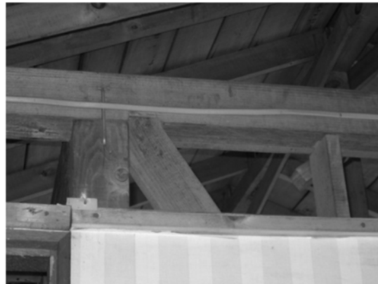
写真Ⅱ.2.2.4 柱頭接合部の例 (金物が使われていない例)
