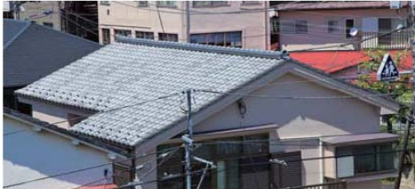
健全な瓦屋根
