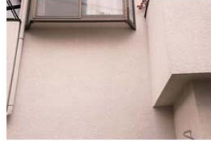
健全な外壁（ひび割れ等がない）
