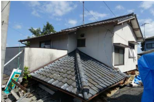
写真2 倒壊した木造住宅
