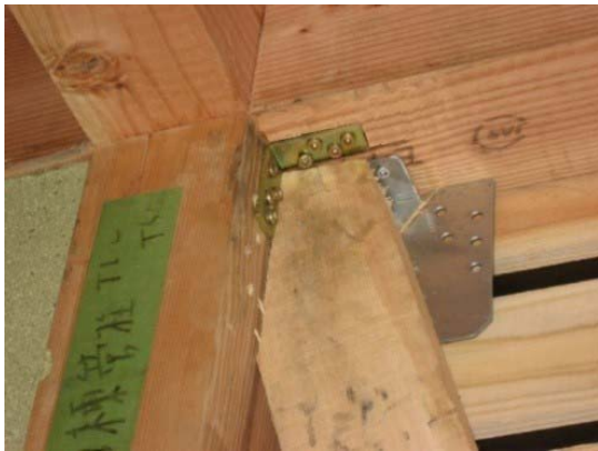
写真Ⅱ.2.2.1 柱頭接合部の例 (金物が使われている例)
