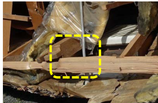
写真3 写真2の住宅の柱頭部
