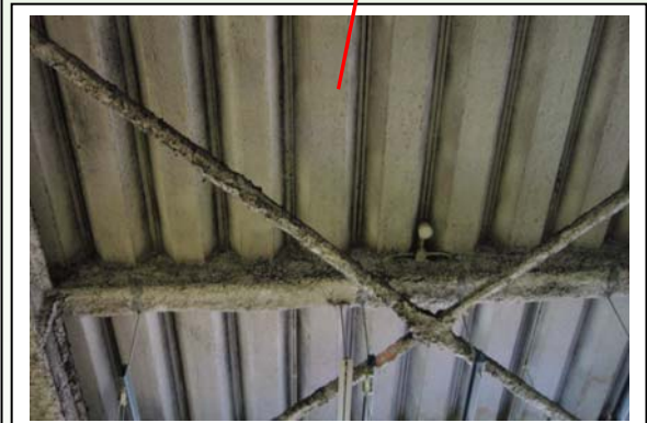
<第1電気室 天井(屋根の凸凹が見える)>
