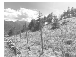
防鹿柵の設置
