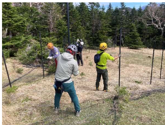
防鹿柵立上げ作業中
