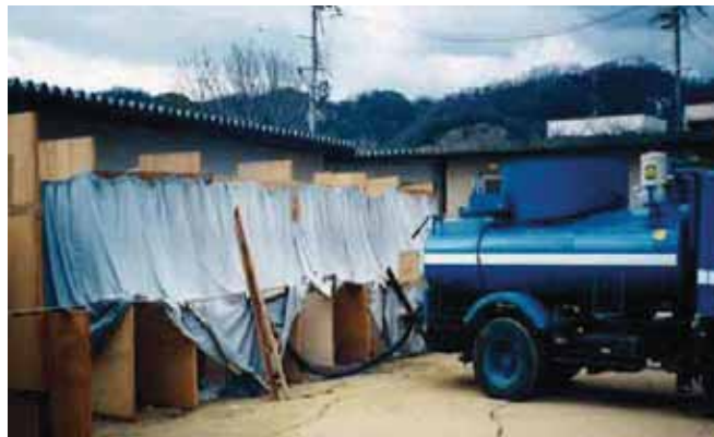
阪神淡路大震災時、素掘りトイレからの汲み取り
