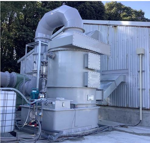
図4 次亜塩素酸水による洗浄塔
