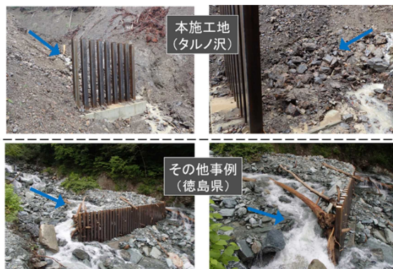
図7 施工事例（VCCO型応急対策工）
