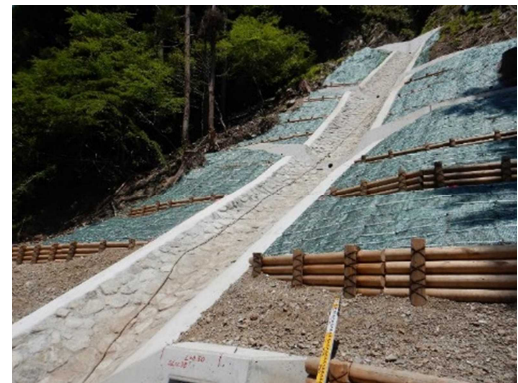
図11 令和4年度施工 練石張水路
