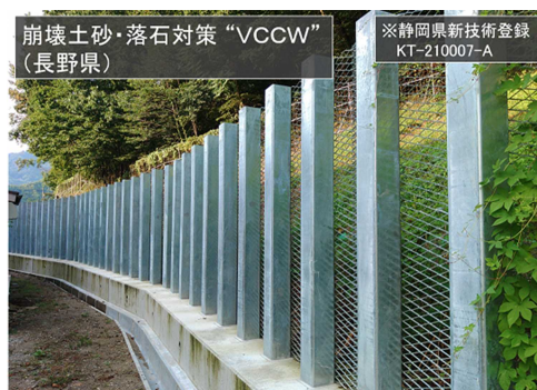
図9 施工事例（崩壊土砂・落石対策工）
