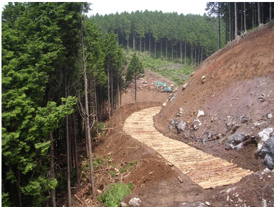
写真1 丸太基礎路盤工 (平成 17 年度 林道諏訪野台線)
