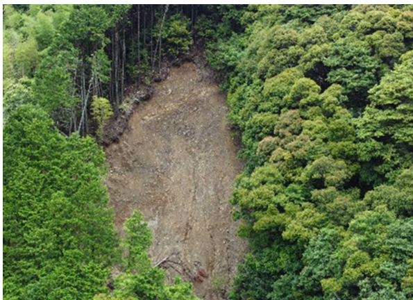
写真4 葵区油山の山腹崩壊
