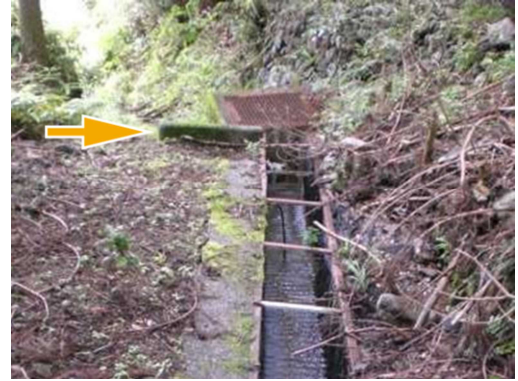
図10 帯工を設置した水路
