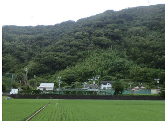
写真2 治山施設施工直後(上)及び森林へ復旧後(下)
