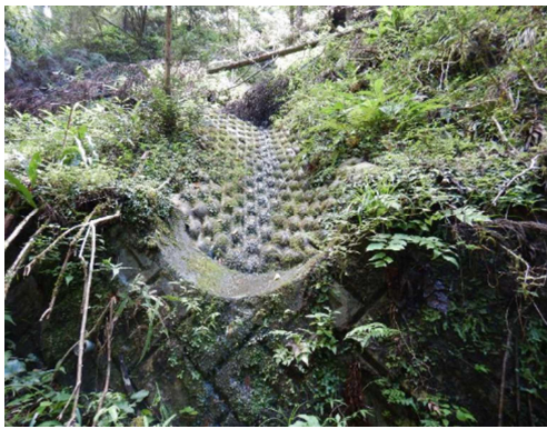
図 12 布製型枠水路
