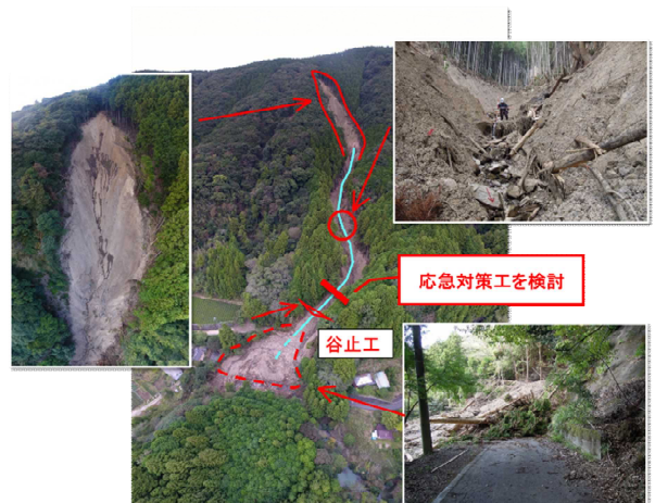
図2 施工地の全景
