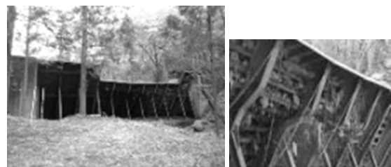
写真3 宮沢のバットレス式治山ダム（左） バットレスの劣化状況（右）
