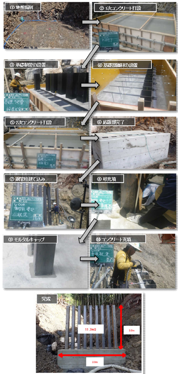
図10 VCCO型応急対策工の施工フロー
