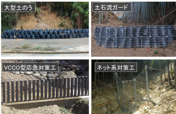
図4 応急対策工の比較工種
