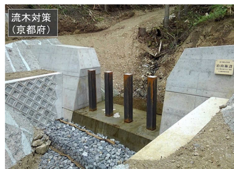
図8 施工事例（流木対策工）
