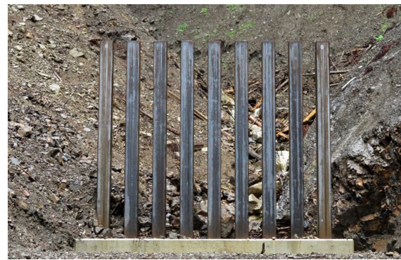
図5 VCCO型応急対策工(本施工地)
