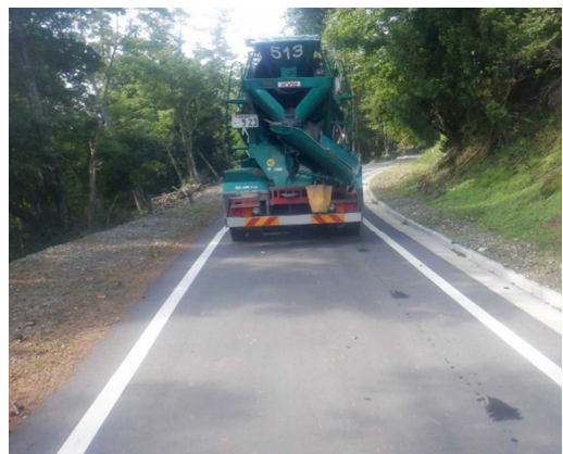
写真3 ジオテキスタイル施工区間を走るアジテータ車(10t)
