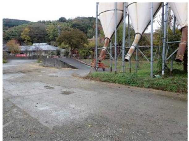
写真6 水たまり埋立て後の様子
