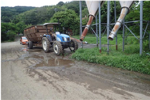
写真4 作業動線上の水たまり
