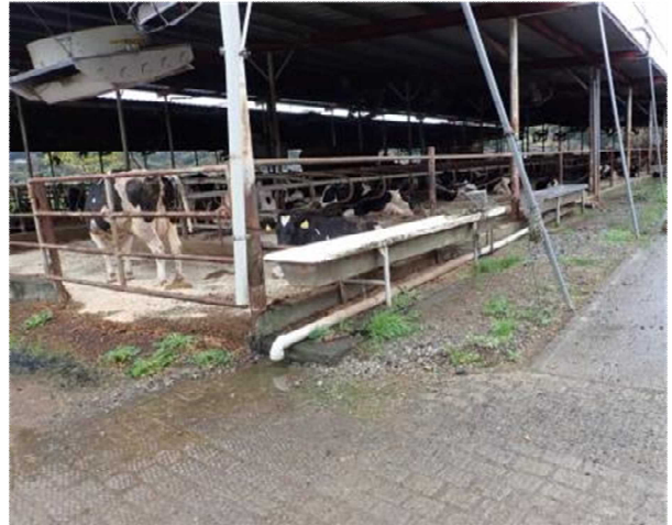
写真5 除草後の様子
