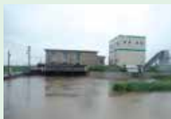
排水機場(毘沙門2期地区)
