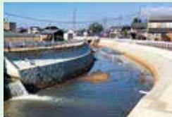
排水路整備(柿沢川南部地区)
