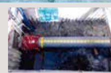
破裂した用水管を迅速に復旧
