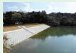
ため池の耐震工事
