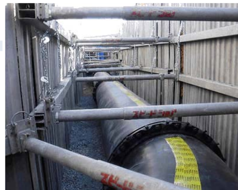
分水工改修工事 (φ1,000ダクタイル管 配管状況)
