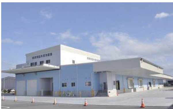
港にある冷蔵庫（焼津市）
