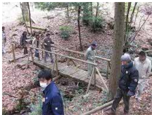
間伐材で造った手づくりの遊歩道
