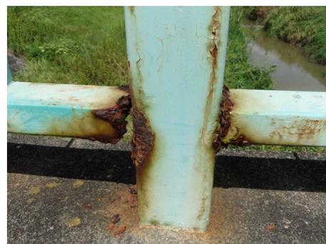
写真2 高欄の著しい腐食
