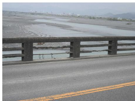
写真1 高欄部材の欠損
