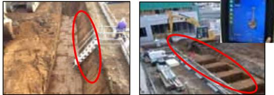
オープンカット法面整形(60°3D) つぼ掘 床付け(3D：2D+深さ)
