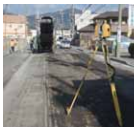
切削後の測量
