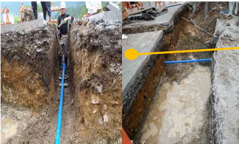
③復旧完了
