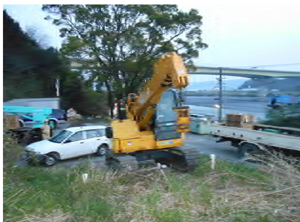
4.9t吊クローラークレーン
