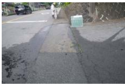
町道側の側溝から溢水し、道路上へ流出
