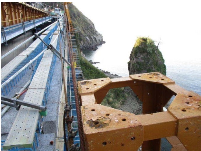
■ P 2 側門型油圧リフター基部（海側）
