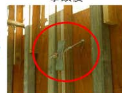
緊結金具が抜ける
