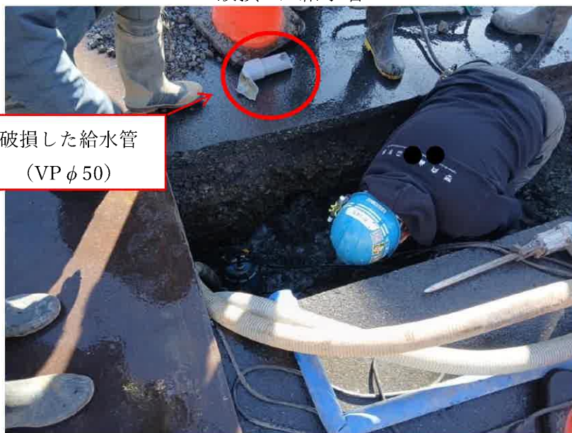
破損した給水管
