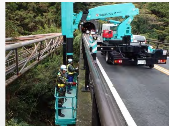
2015年の点検状況
