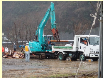
重機によるがれきの撤去
