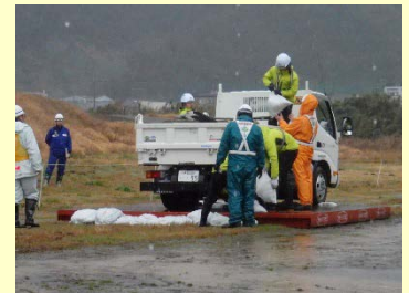
橋梁段差の復旧
