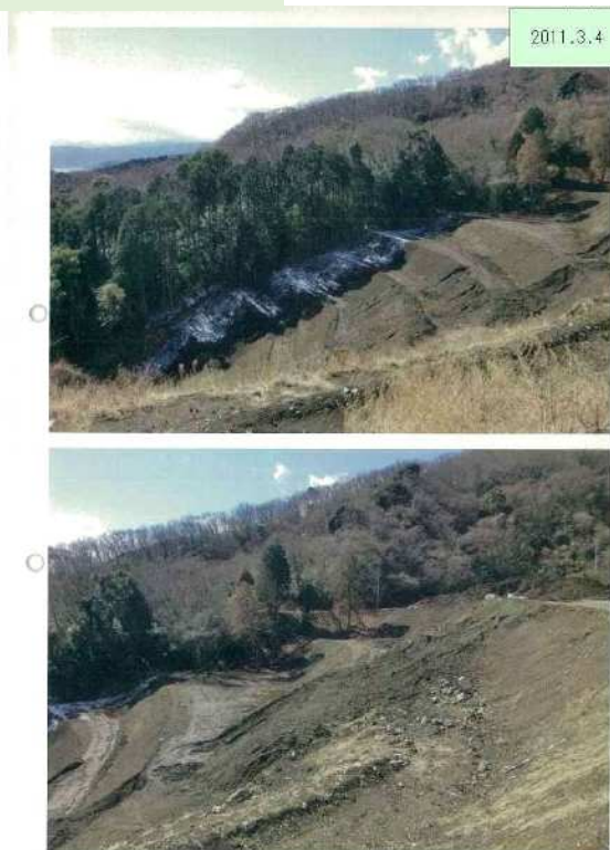
写真6 2011(平成23)年3月4日 県及び市で合同調査
