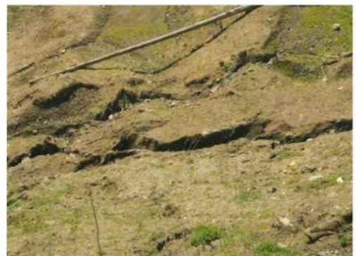
法面の浸食発達状況
