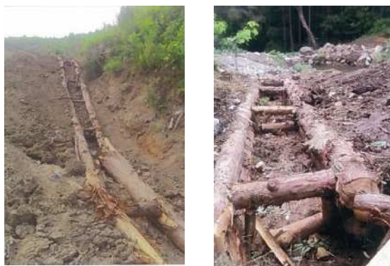
2011. 8 法面補修工事 (熱海市写真 8)
