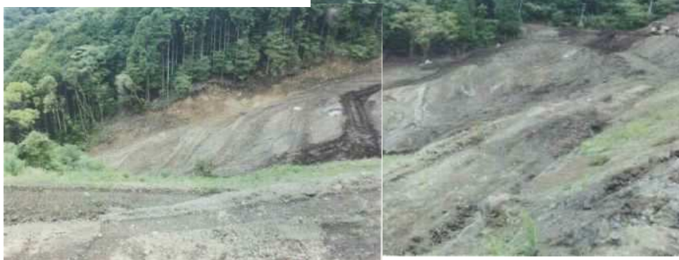
E社の盛り土完了(植生未施工)
