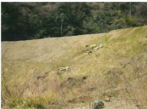
法面の緑化状況
