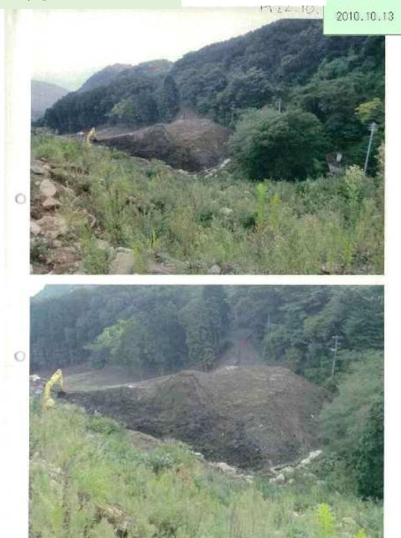
写真4 2010(平成22)年10月13日 調圧槽手前に大量の土砂を確認
