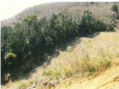
残土による盛り土法面
