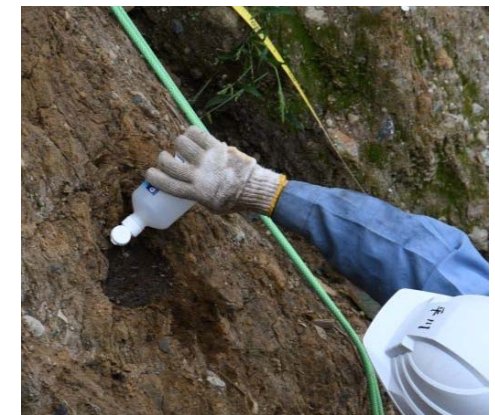
注水の状況(調査箇所1)。 水平面を作り土が流出しないよう注水。 目視で飽和を判断。
