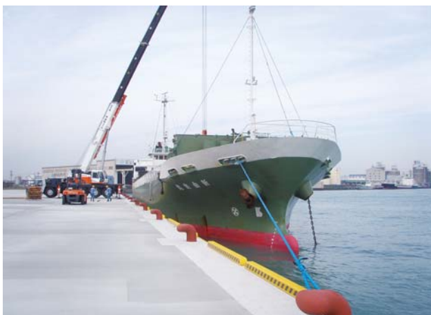
公共南岸壁(平成23年10月完成)初荷役の様子
