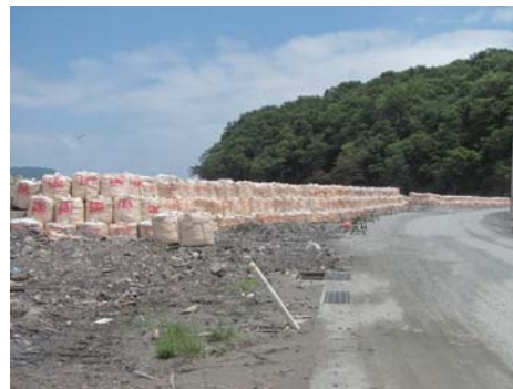
大型土のう設置
