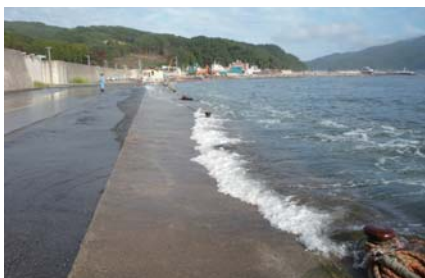
漁港施設の浸水
