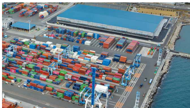
新興津国際物流センターとコンテナターミナル
