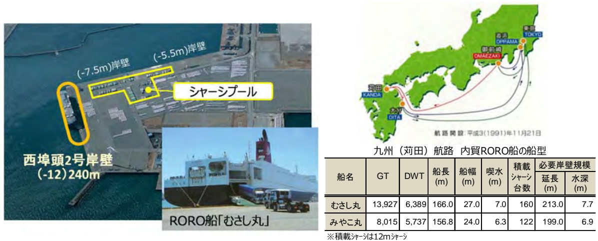
図 2-24 駿河湾港の内貿 RORO ターミナルの整備状況
