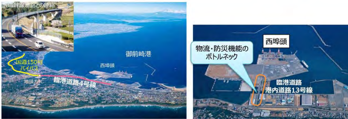
図 2-44 御前崎港の背後幹線道路との接続状況
