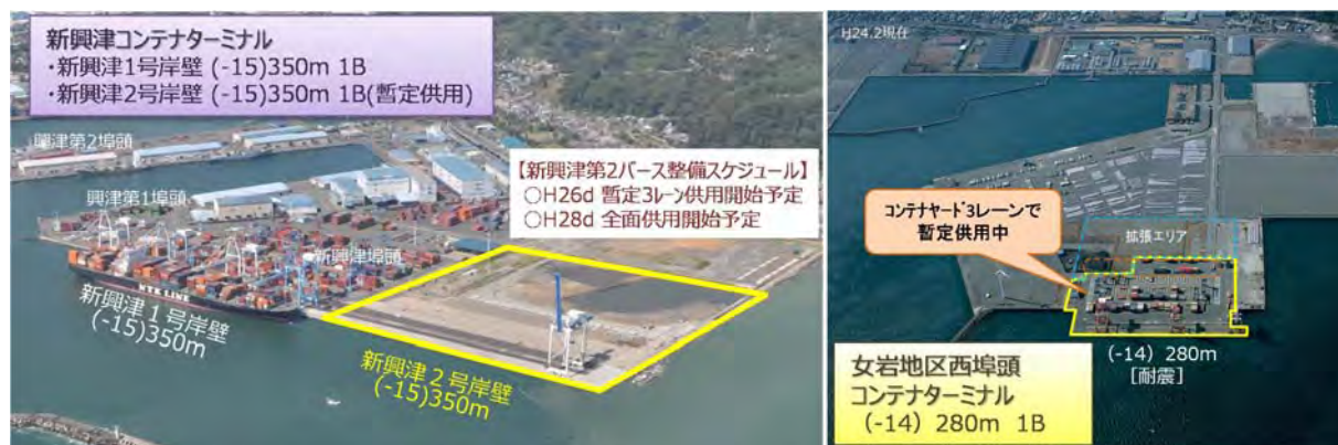
図 2-22 駿河湾港のコンテナターミナルの整備状況
