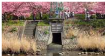
浜川樋門（下田土木）
