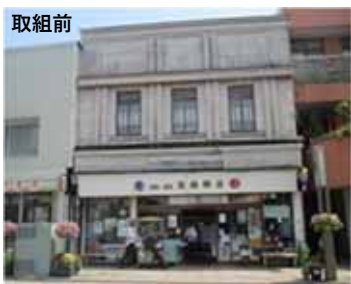
三島市（看板建築の保全）
