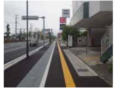
無電柱化完了（H29年度）
