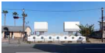
初川水門（熱海土木）
