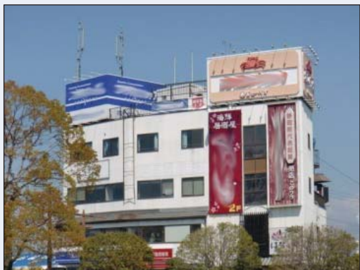
新富士駅周辺地区は、富士市屋外広告物条例（景観形成型広告整備地区）として、広告塔の高さ・面積の制限強化や屋上広告物の禁止、壁面広告の面積制限の強化及び色彩の制限を行います。
