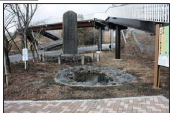
着手前の様子
