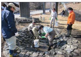
池の水を抜き、たまった土砂を撤去
