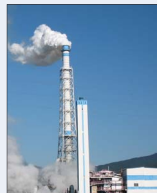
工業地色彩ガイドラインに基づく煙突の修景(富士市)
