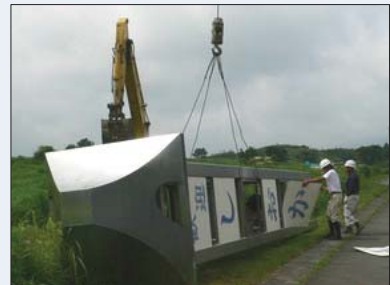
歓迎塔の撤去作業の様子
