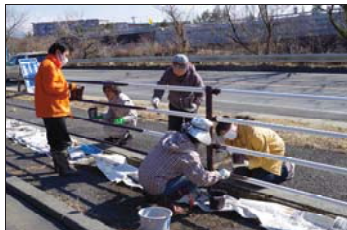
看板を撤去し、柵を塗装
