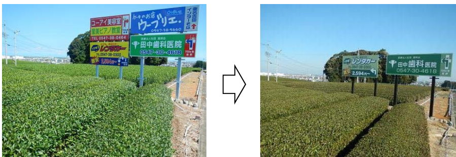
色彩ガイドラインに基づき板面と支柱の 色彩を改修した案内図板 (県道島田吉田線 BP 沿い)
