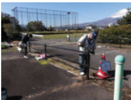
ガードパイプ塗替え(御殿場市)
