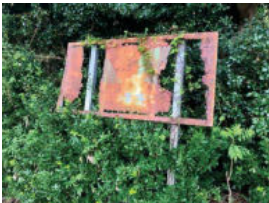
劣化して朽ちた看板
