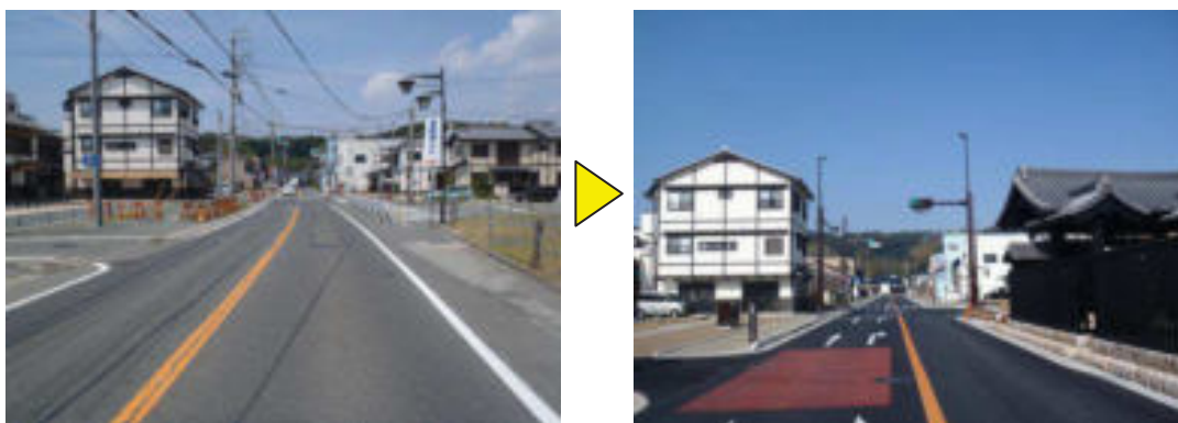
新居関所周辺の無電柱化(前)
