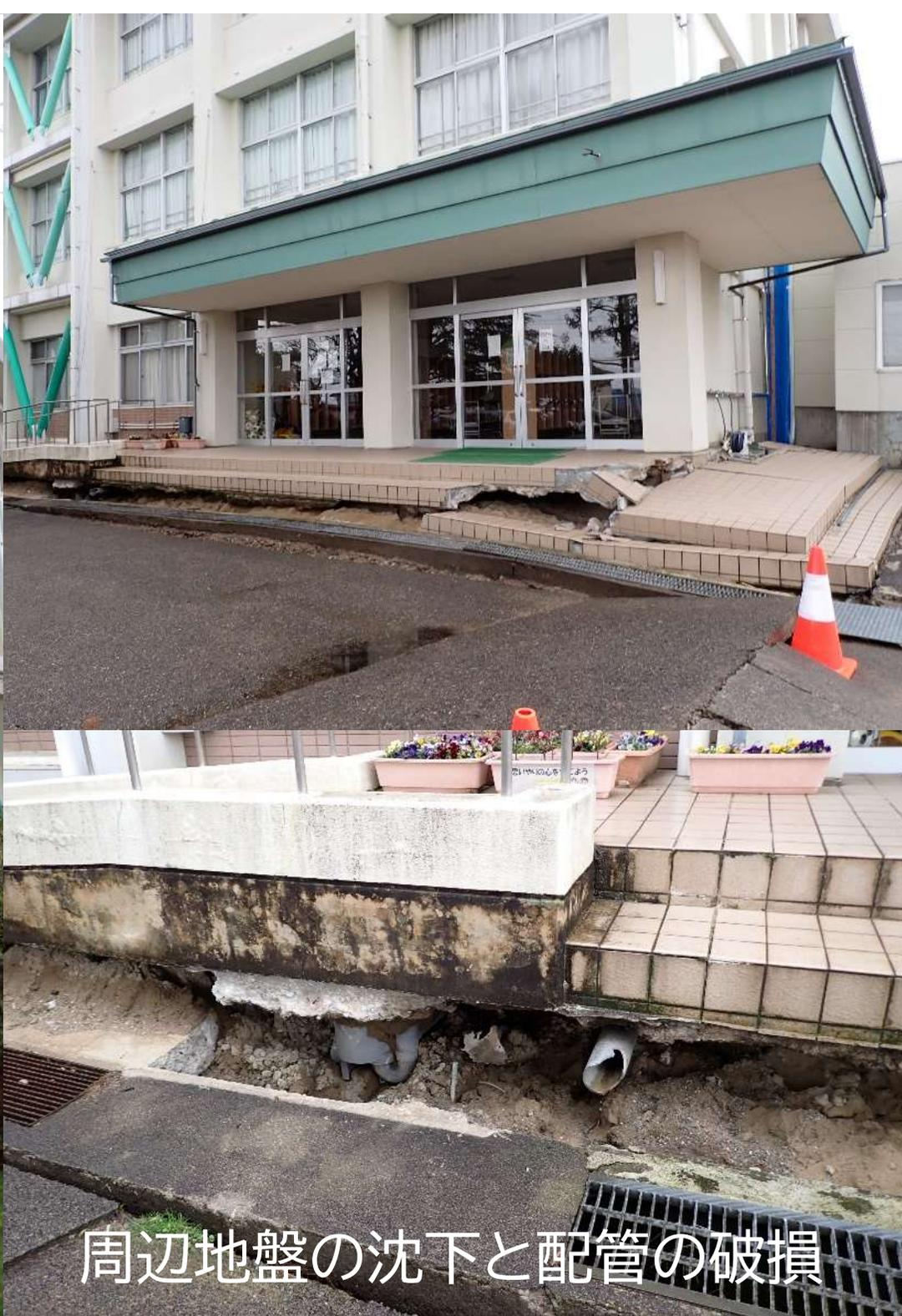
周辺地盤の沈下と配管の破損
