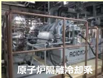
高圧型原子炉注水設備(タービン駆動)
