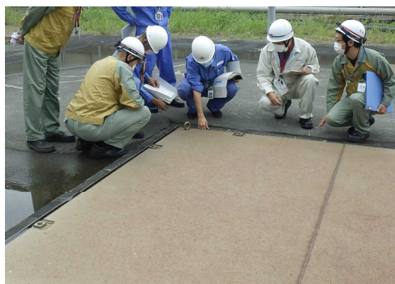
水密蓋の状況を確認
