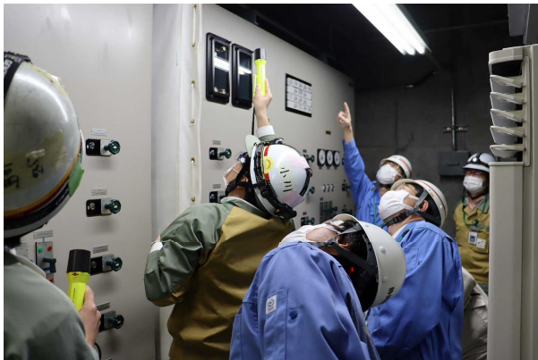
耐火隔壁の設置状況を確認
