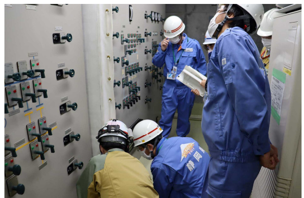
耐火隔壁接地面の固定状況を確認
