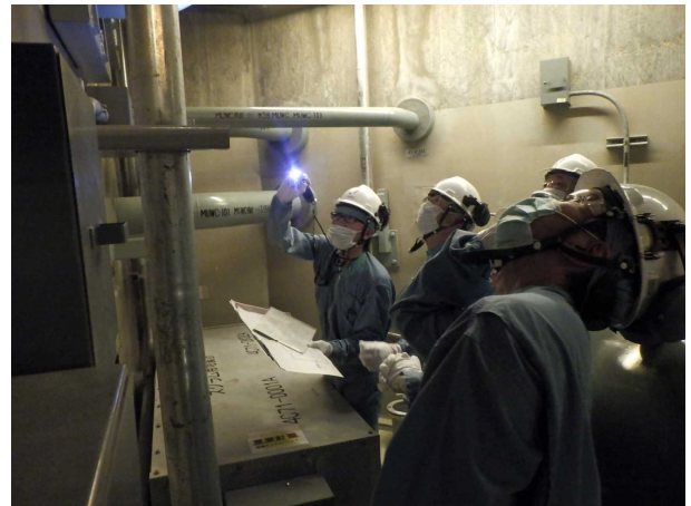
追設された配管の設置状況を確認
