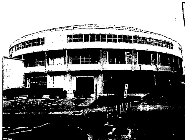
沖縄セルラーパーク那覇(屋内運動場)外観
