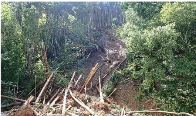
↑「着工前」 (令和元年9月災害)
