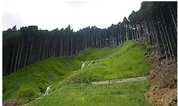
崩壊地の早期緑化を図る山腹工(川根本町東藤川)
