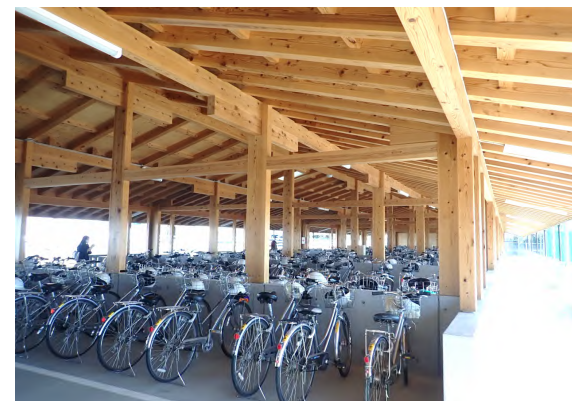
▲県産材を利用した木造駐輪場（御前崎市立浜岡中学校）
