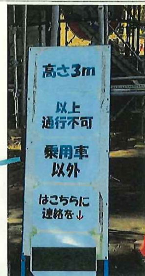
西側SL看板設置状況
