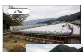
現在、工事も着々と進んできていて、架設された 高架橋には、床版の打設が完了しています。 今後は、舗装や側道、雨水貯留施設などの工事を 行っていく予定です。
